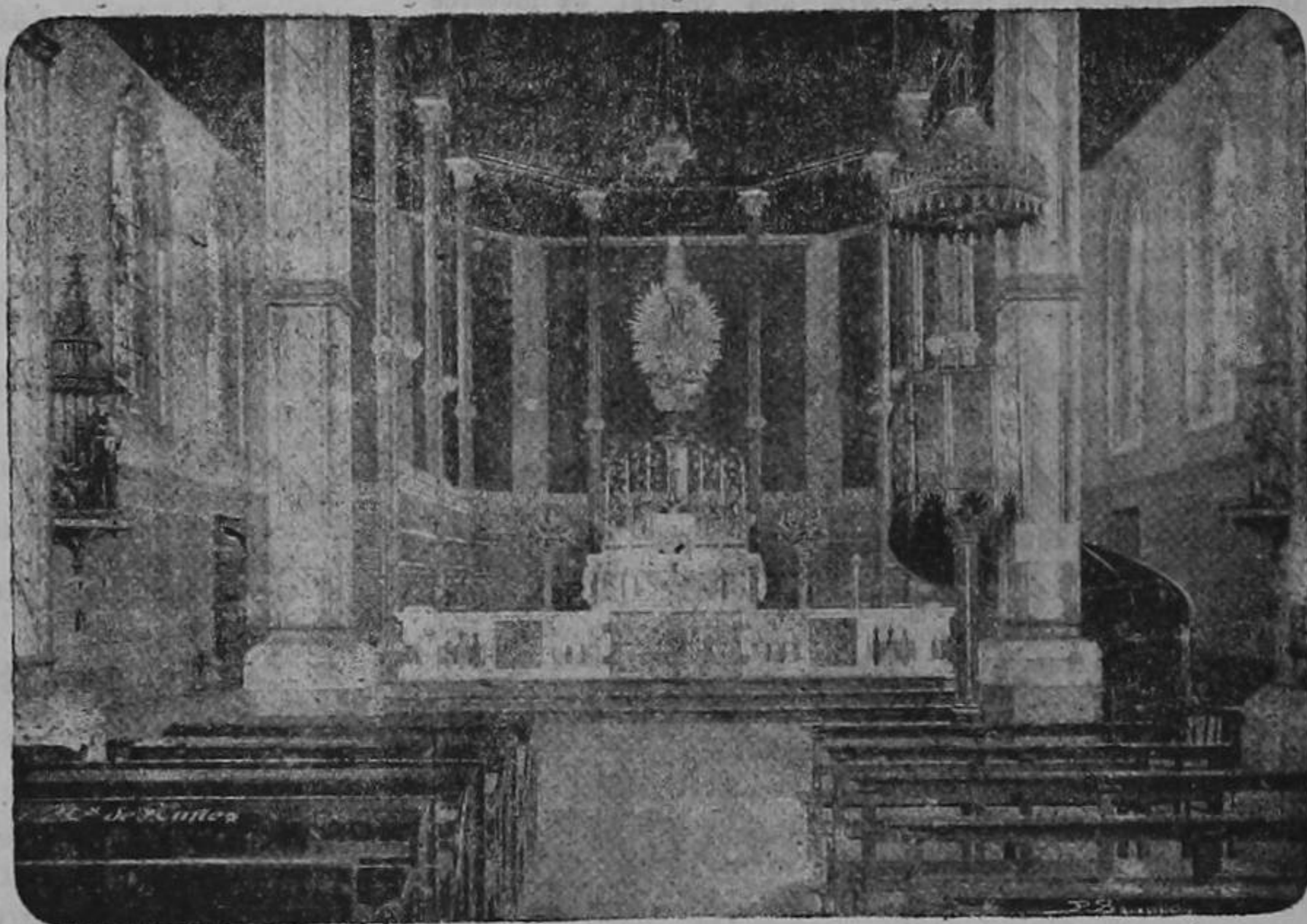
Interior del templo
